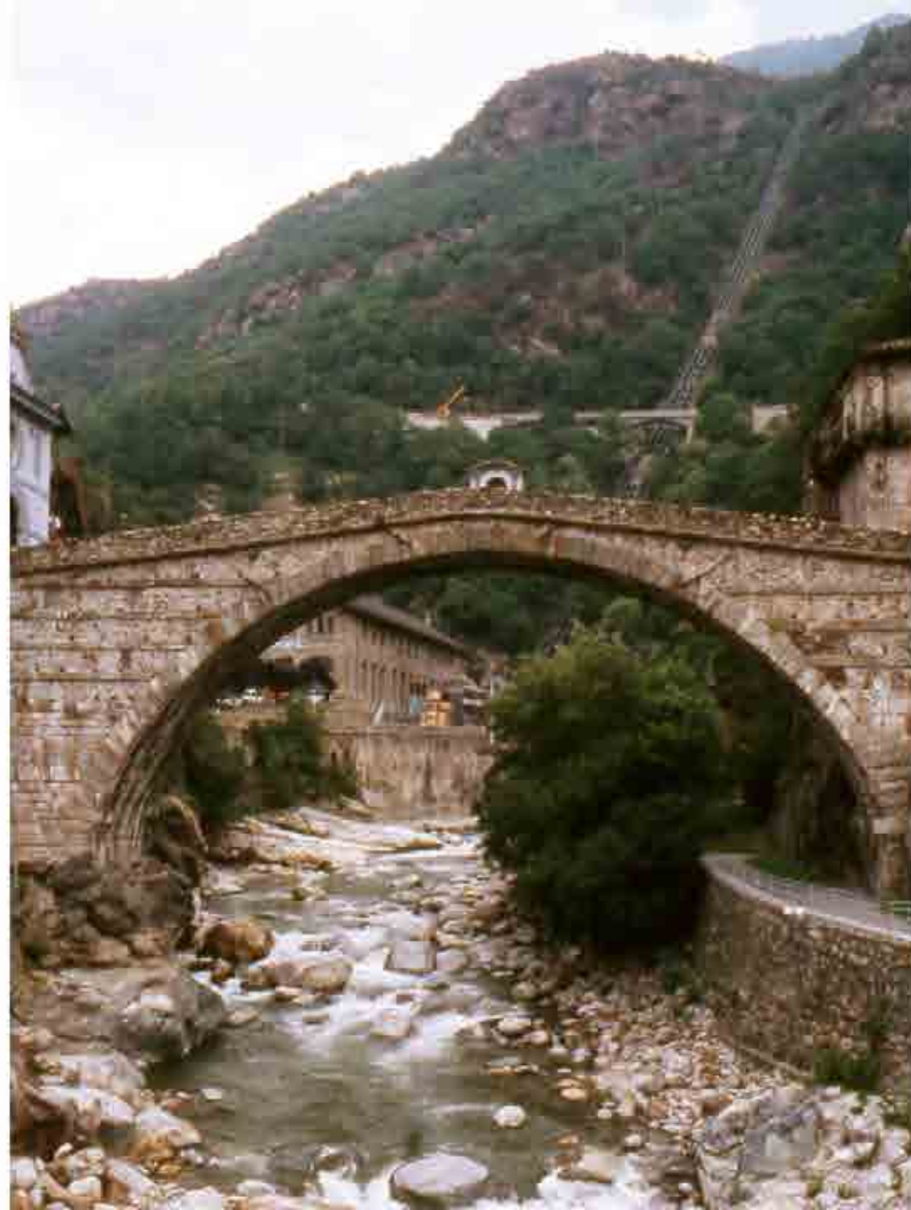
Pont Saint Martin – Ponte romano
