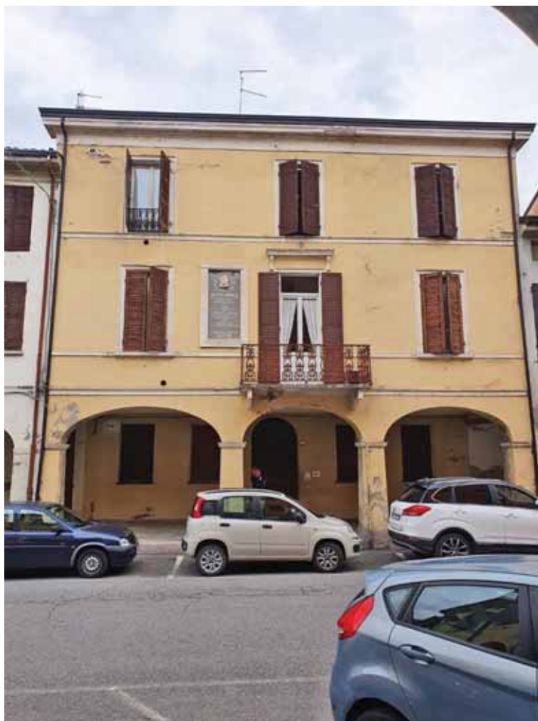
fig. 2 - Brescello, Sede della Società Operaia di Mutuo Soccorso, donata da Luigi Zatti nel 1884
