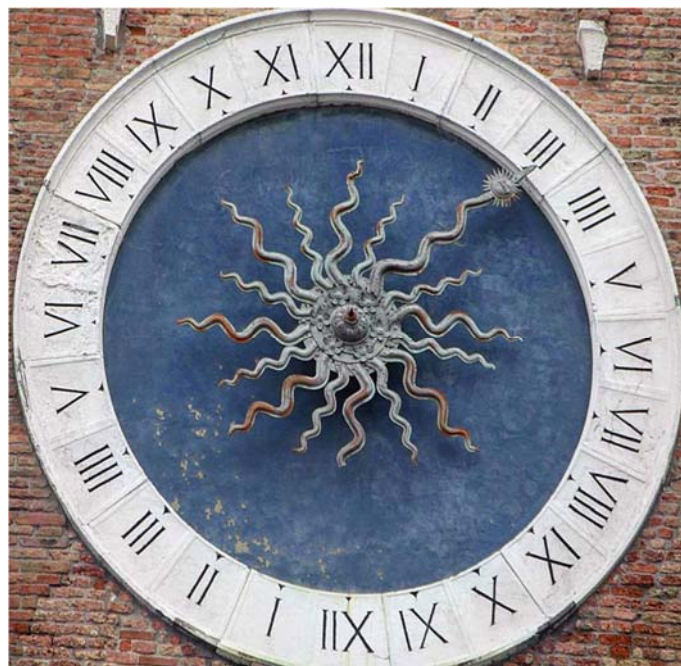
fig. 3 – Orologio di Chioggia , il quadrante, a orario italico, suddiviso in 24 ore con un unico raggio della stella centrale che indica l'orario 14
