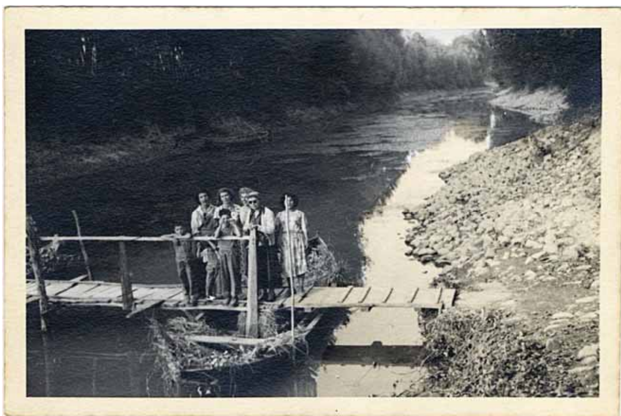
fig. 8 – Il ponticello, sostenuto da barconi di legno, che nel passato permetteva l'attraversamento dell'Enza a pedoni e ciclisti (Archivio Azzi – Brescello)
